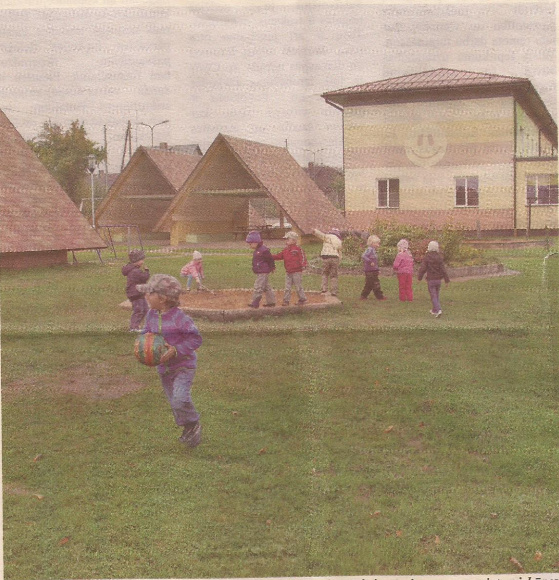
Attēlā: Redzamākie darbi, kas šovasar paveikti 3. bērnudārzā, ir jaunu jumtu un novietņu izbūves.
